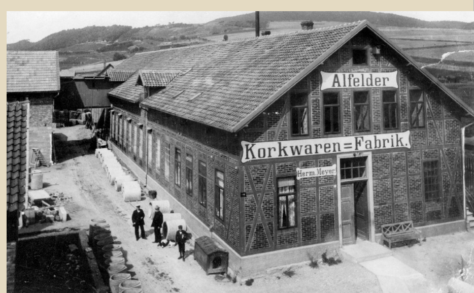
Der Ursprungsbau der Fabrik an der Hildesheimer Straße ca. 1900
